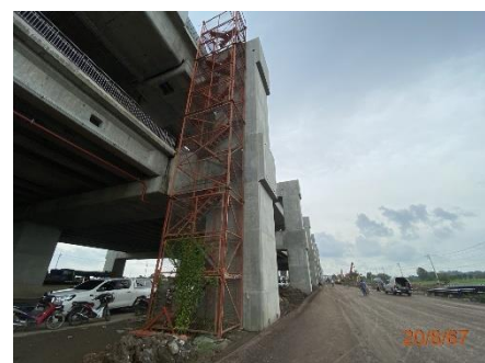
ภาพที่ 2.2-44 บันไดสำหรับใช้ก่อสร้าง
