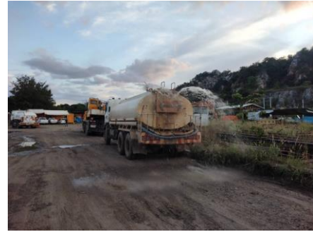
ภาพที่ 2.2-15 การฉีดพรมน้ำบริเวณที่ปูฝุ่นละออง
