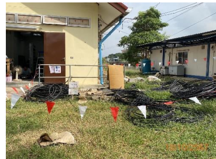
ภาพที่ 2.2-40 การกั้นแนวเขตบริเวณพื้นที่ที่เป็นหลุม
