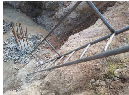
ภาพที่ 2.2-47 บันไดขึ้นลง สำหรับพื้นที่มีการขุด
