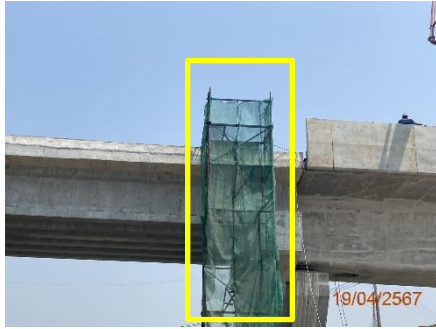
ภาพที่ 2.2-45 นั่งร้านและการตรวจสอบที่ใช้สำหรับงานก่อสร้าง
